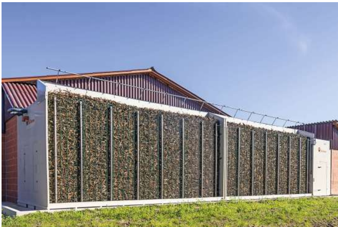
Fot. 11. Bio-filtr powietrza firmy BIG-DUTCHMAN
